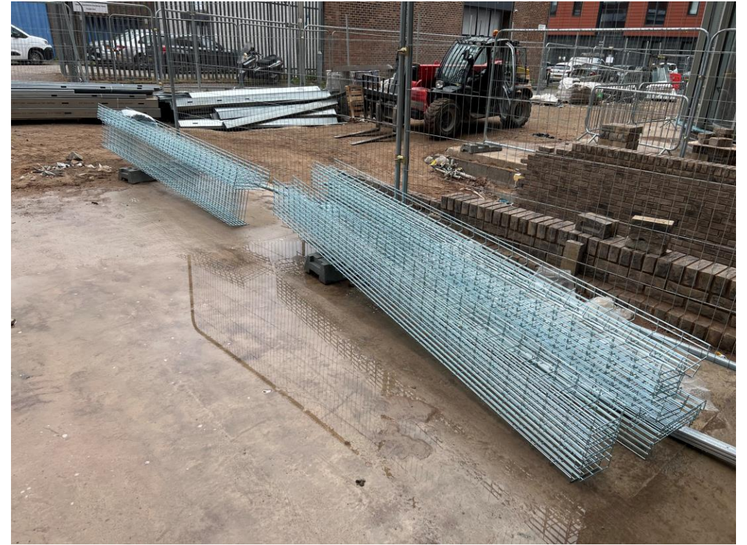
Overhead service conduit
