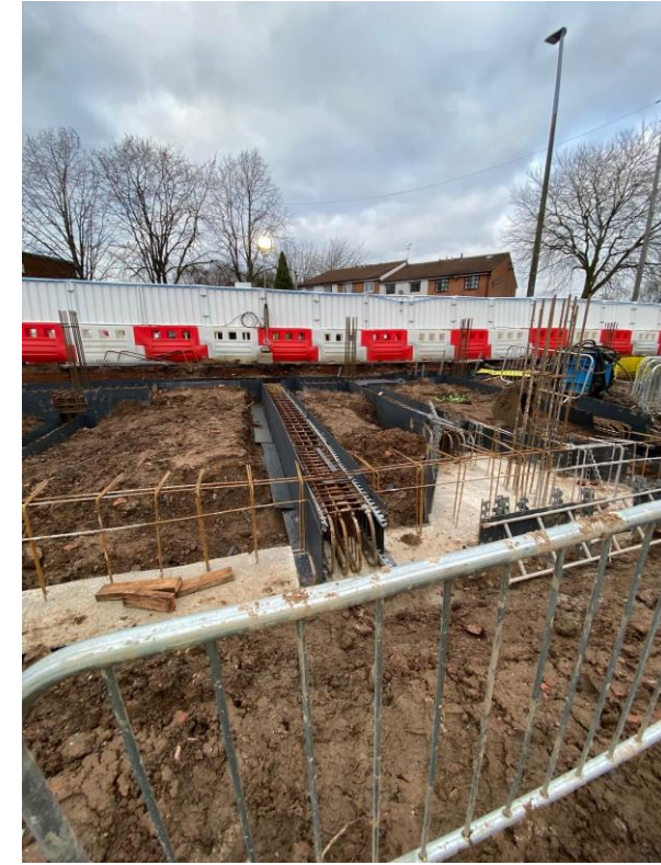
Block B – Pile cap reinforcement ready for concrete pour
