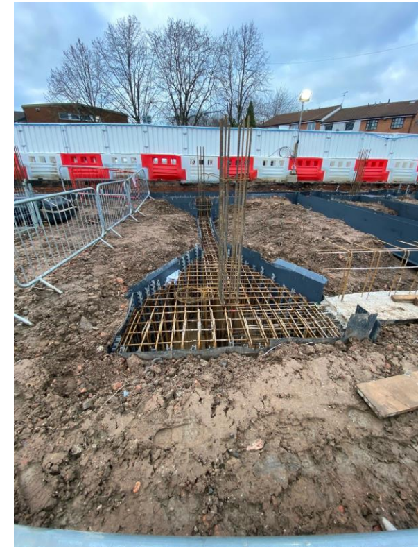
Pile cap reinforcement ready for concrete pour
