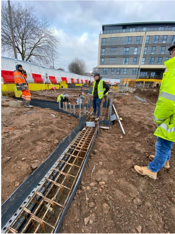
Block B - Pile cap reinforcement ready for concrete pour
