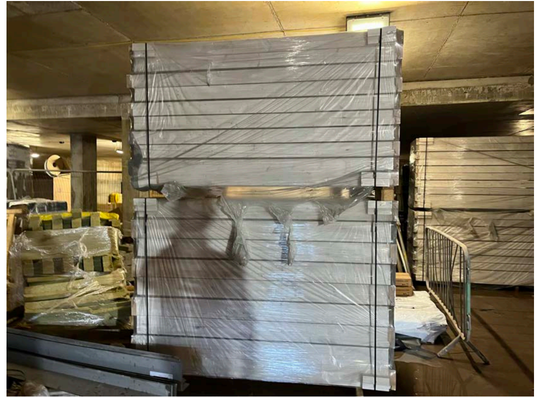
Door frames on site
