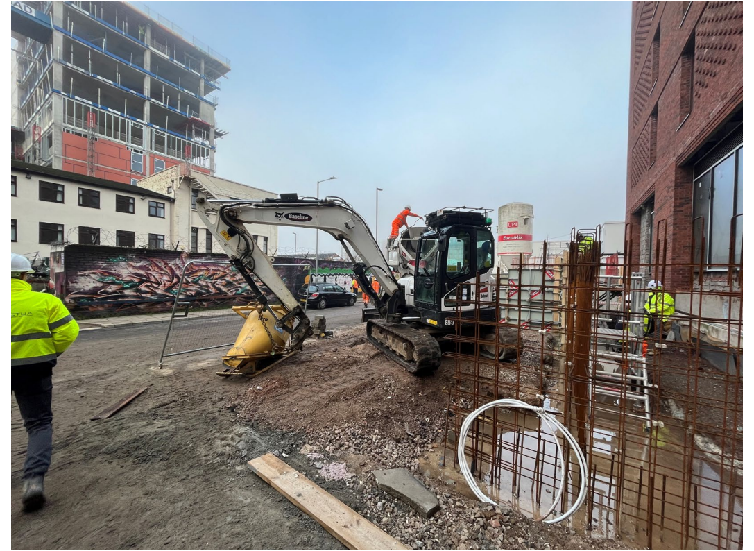
Concrete pour for retaining wall ongoing
