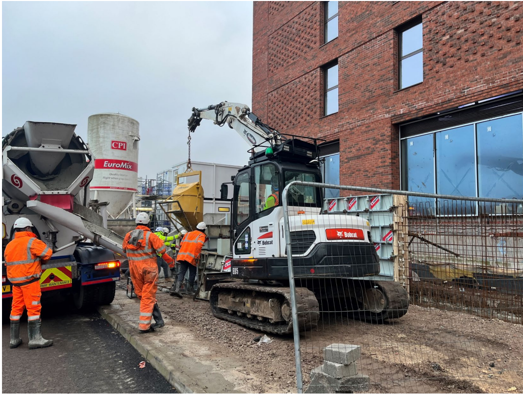
Concrete pour for retaining wall ongoing
