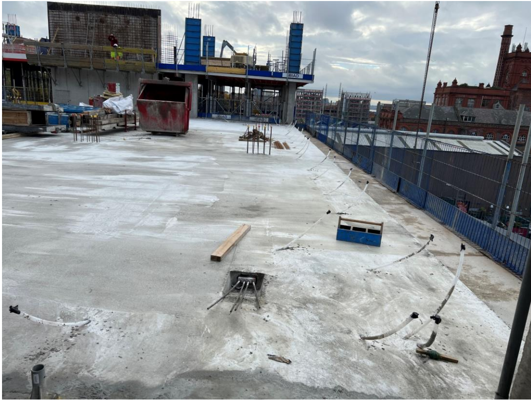
Section C – Level 5 concrete pour complete
