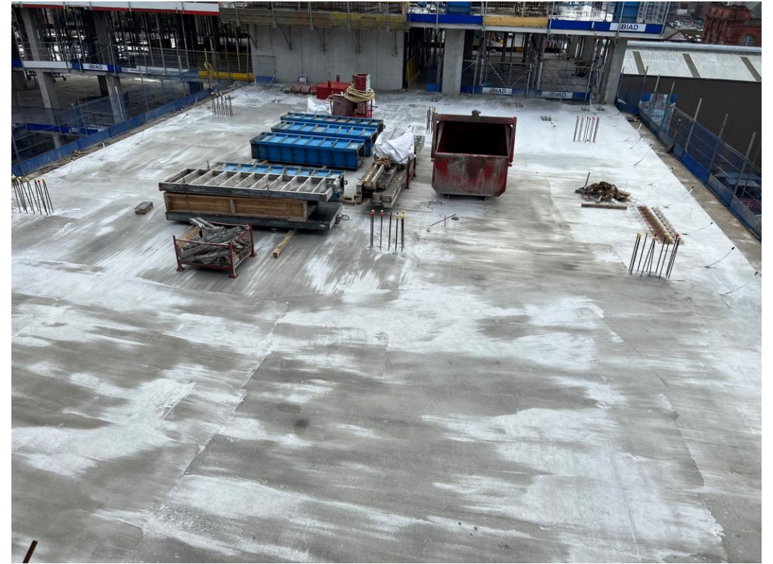
Section C – Level 5 concrete pour complete
