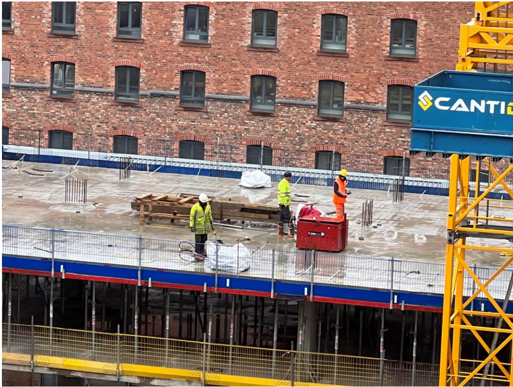
Section C – Level 3 slab pour complete
