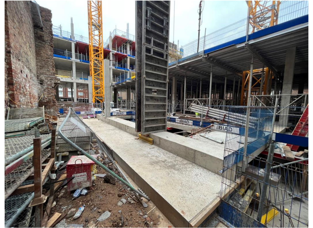
Podium - Columns & slab pour ongoing
