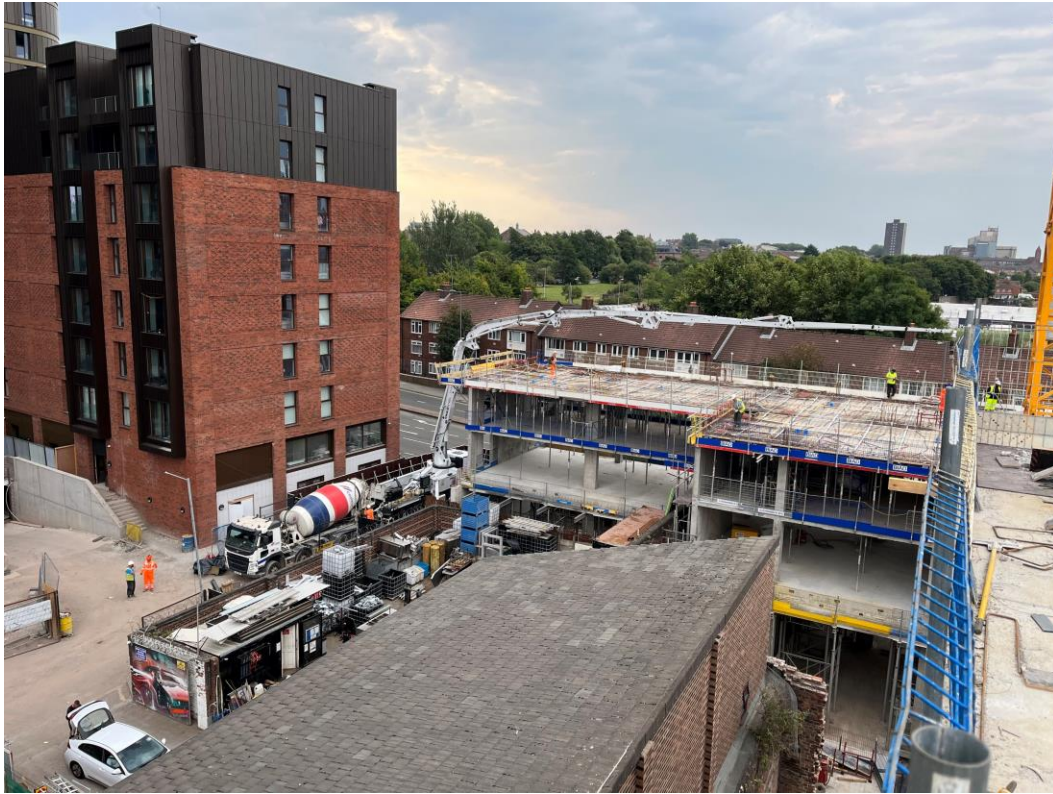
Section B – Concrete slab pour ongoing
