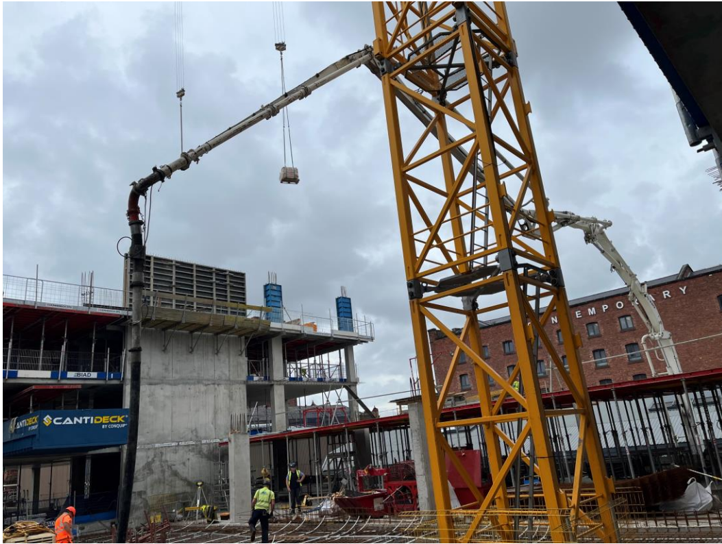
Podium – Slab pour commenced
