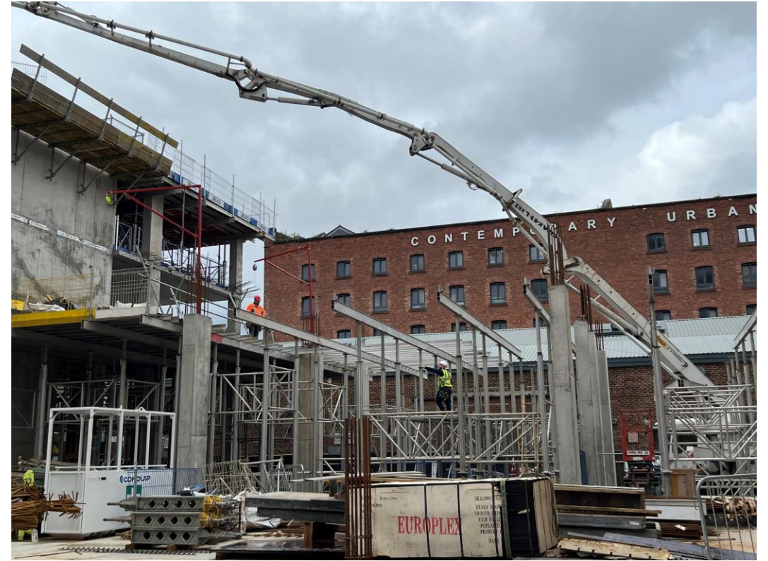
Zone B – Concrete slab pour ongoing
